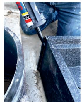
5. Gehrungen und Schrauben mit Montagekleber verschließen
